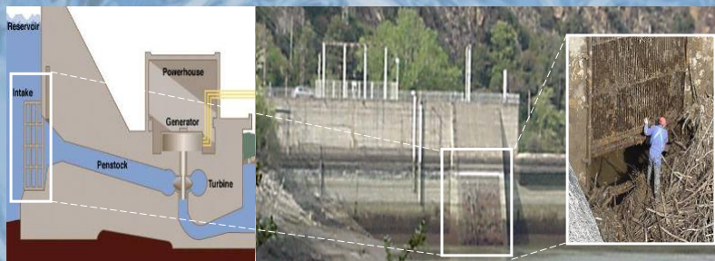
Fig. 1 Rejas de protección de la entrada a la galería (Pasteral - Girona)
